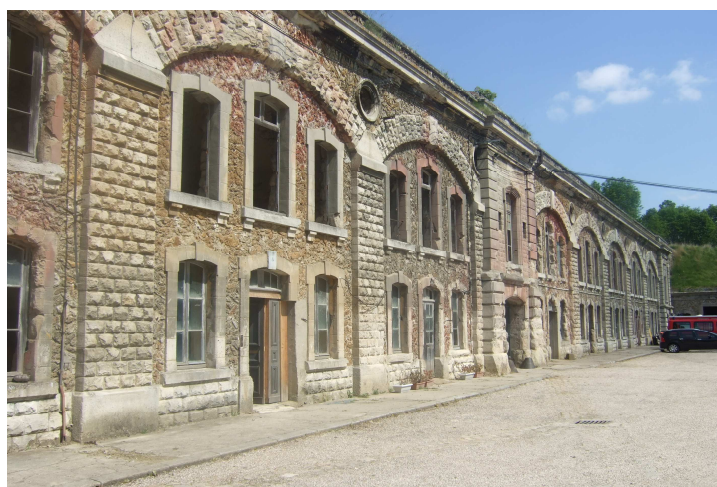
3 : corps de bâtiment du fort du trou d'Enfer
