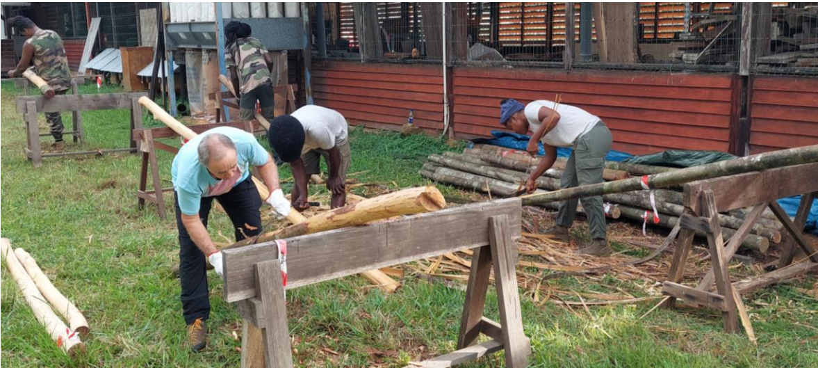
Ecorçage à la plane de 140 éléments (chantier participatif)
