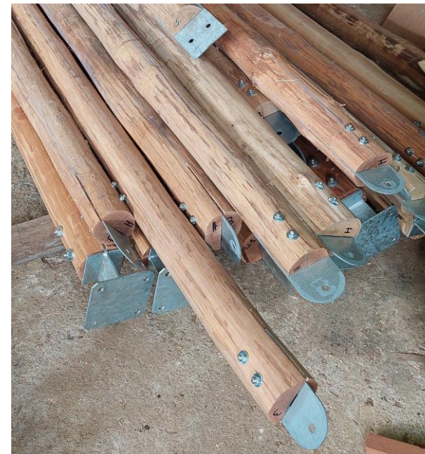
3 – Fixation des différentes ferrures
