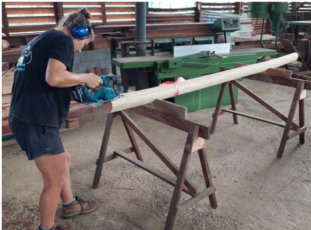
2 – Usinage de la fente en âme
