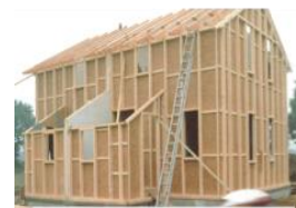
Fig 7 : charpente, ossature et panneaux de
