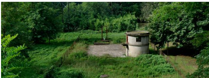
Figure 4. Station de captage d'eau potable entourée de son périmètre de protection - © Laurent Mignaux/METL-MEDDE
