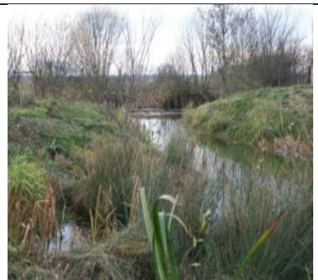
Aménagement de mares pour favoriser la dépollution des eaux de drainage.
