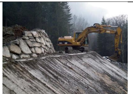
Figure 3 : construction d'une route forestière aux Houches (photo Pugnat)
