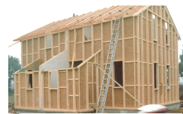
Fig 7 : charpente, ossature et panneaux de
