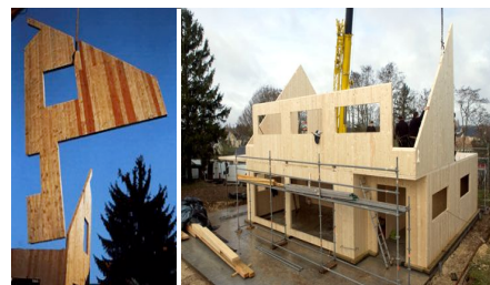
Figure 14. Maison à ossature bois (à gauche) et Figure 15. Maison bois à panneaux porteurs en sapin-épicéa, et exemple de panneau à gauche en pin (à droite)
