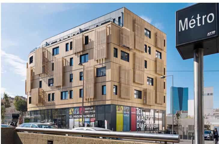
Figure 7. Immeuble de bureaux en bois de 5 étages à Marseille - Le système constructif est mixte : CLT (murs de façade et planchers) / poteau poutre de bois lamellé / noyaux béton - Source : CLT France
