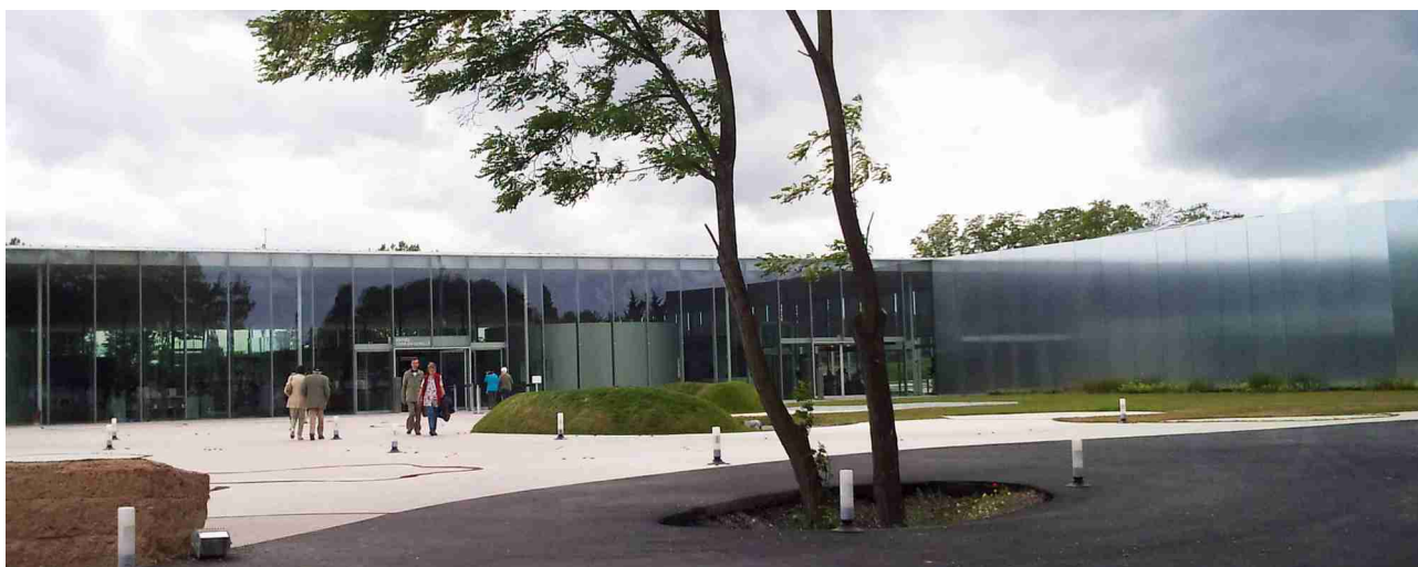
Figure 4. Musée du Louvre à Lens, Catherine Mosbach, architecte paysagiste (crédit S. Keravel). L'esthétique des formes paysagères exprime la mémoire minière du site, l'allusion étant métonymique (la partie pour le tout) : la surface noire (pour le charbon) où s'enracine l'arbre (la vie) évoque l'attachement de la société locale à sa mémoire vernaculaire.
