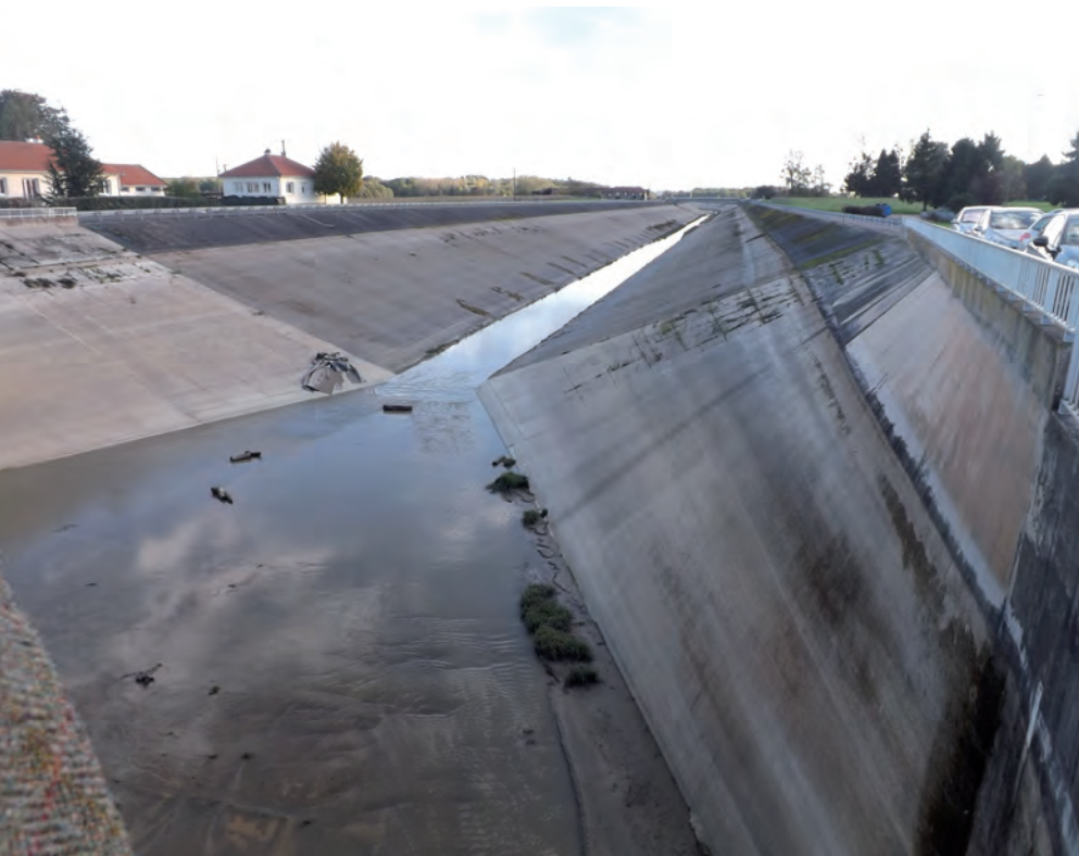
Arrivée du canal d'alimentation du lac d'Orient.
