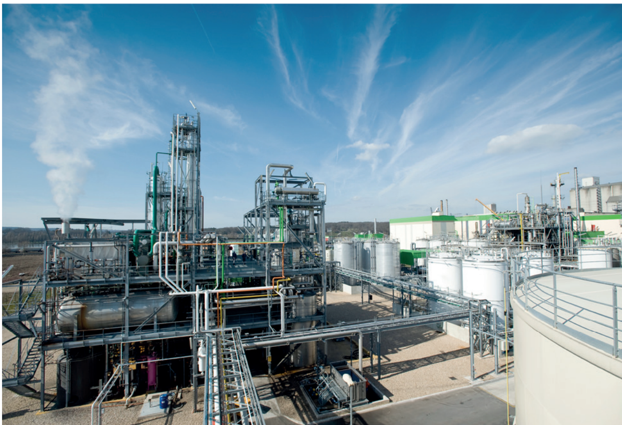
Unité de transestérification de Grand-Couronne
