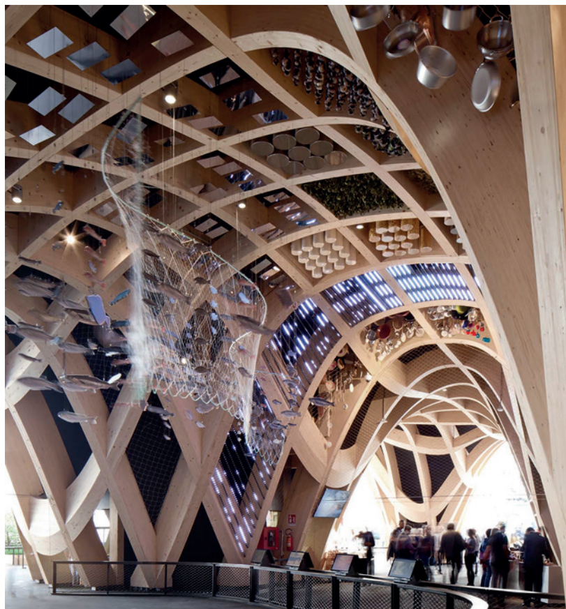
Une magnifique réalisation à l'exposition universelle de Milan : la pavillon France, en lamellé-collé.
