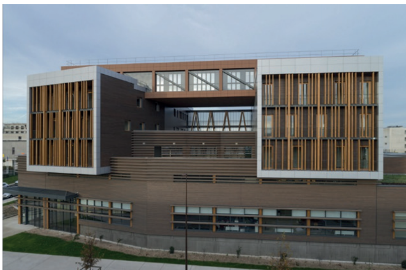
Le siège de l'Institut Technologique FCBA (Forêt Cellulose Bois-construction Ameublement), à Champs sur Marne, construit entièrement en bois.
