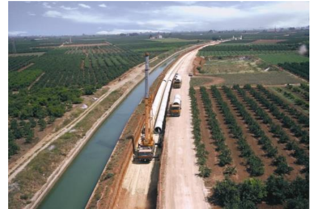
Travaux pour la modernisation de l'Acequia Real du Júcar
