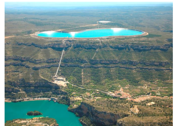
Aménagement hydroélectrique réversible Cortes La Muela
